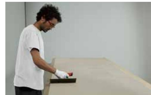
Applicare l'adesivo con una doppia spalmatura a letto pieno, prima sul retro della lastra e poi sul sottofondo, facendo attenzione a coprire anche gli angoli e i bordi ed evitare vuoti d'aria tra il sottofondo e la lastra. Stendere il collante di volta in volta solo sulla superficie interessata dalla posa di una lastra per evitare la formazione di pellicole superficiali che ne compromettano l'adesione.
