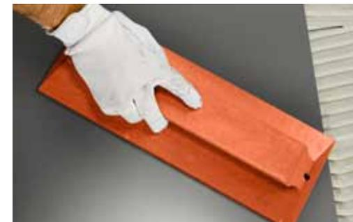
Battere sulla superficie utilizzando una spatola gommata facendo attenzione a eliminare vuoti e bolle d'aria. Verificare sempre la perfetta adesione degli angoli e degli spigoli. Non calpestare il pavimento durante e dopo la posa rispettando i tempi di pedonabilità indicati dal produttore del collante.
