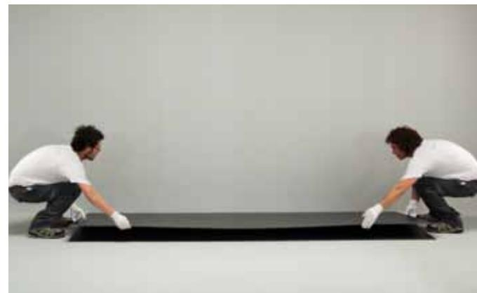
Sovrapporre più lastre in orizzontale, assicurandosi che le superfici siano pulite e che il piano di appoggio sia perfettamente planare. È possibile sovrapporre fino a un massimo di **50 lastre Laminam 3**.
