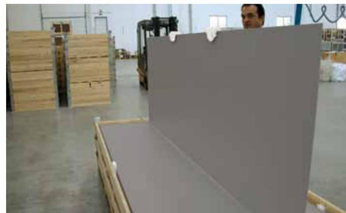
Posizionare l'imballaggio in prossimità della superficie da rivestire. Sollevare la lastra per il lato lungo fino a portarla in posizione verticale.
