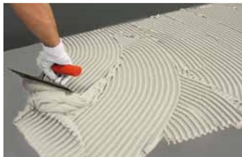
La scelta della spatola da utilizzare dipende dalla finitura e planarità del sottofondo ed è direttamente proporzionale alle dimensioni della lastra. In via generale per una lastra **1000x1000 mm**, si consiglia di usare una spatola con denti inclinati di 6 mm per il fondo e una spatola con denti inclinati di 3 mm per il retro della lastra.
