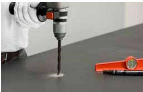
Per realizzare fori aventi un diametro massimo di **8-10 mm**, utilizzare punte da vetro o gres porcellanato al tungsteno o diamantate montate su trapani elettrici. Non eseguire l'operazione in modalità a percussione e iniziare con una bassa velocità di rotazione. Non esercitare sulla superficie una pressione eccessiva. È consigliato raffreddare ad acqua il punto d'attacco e l'utensile.
