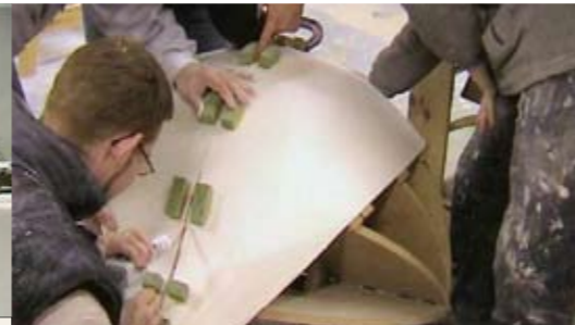
Applicazione dell'adesivo DuPont™ Corian® nella giunzione
